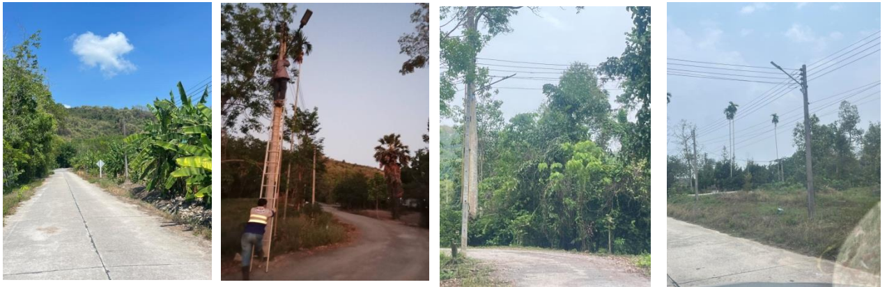
โครงการขยายผิวจราจรถนนคอนกรีตเสริมเหล็กสายเขาตะแบก ซอย ๒ หมู่ที่ ๙
