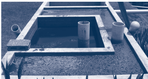
รูปที่ 10 การดักกากตะกอน
